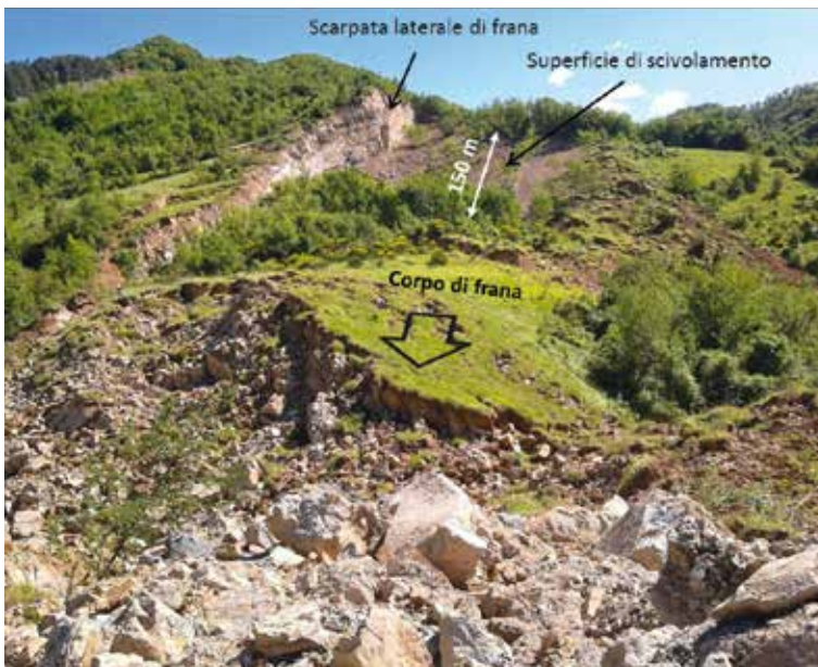
Figura 4 - Foto frontale della frana di Poggio Zampiroli (Brisighella, RA). Il corpo di frana è scivolato verso valle per oltre 150 m muovendosi lungo un piano di strato.
