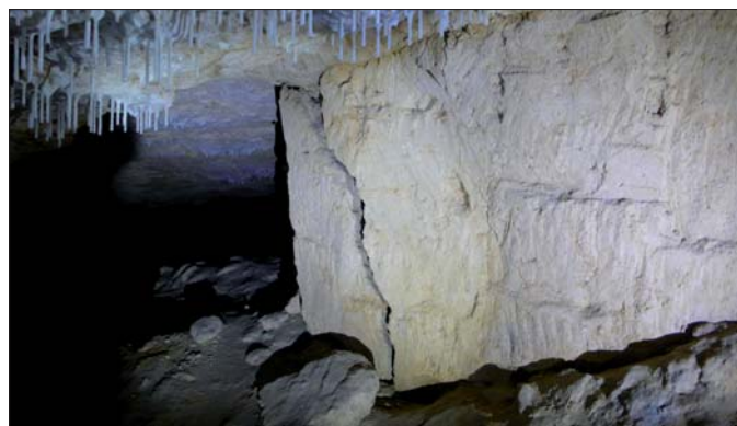
Figura 9 – Pilastro con fratturazione.
