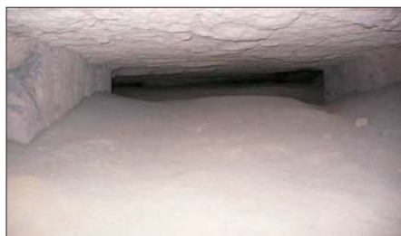
Figura 7 – Detriti fini accumulati nella zona C della latomia.
