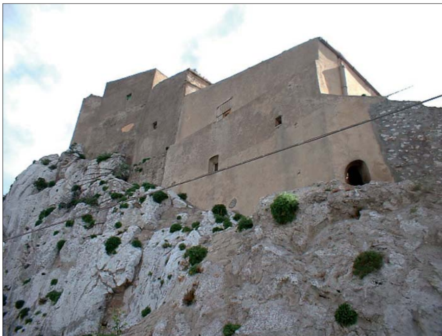
Figura 6 – (Punto 4) Calcari ad Ellipsactinia, intercalazione tipica entro i litotipi della Formazione Crisanti. Essi hanno rappresentato, come mostra l'immagine, ottimo terreno di imposta per gli edifici del Centro Storico.
