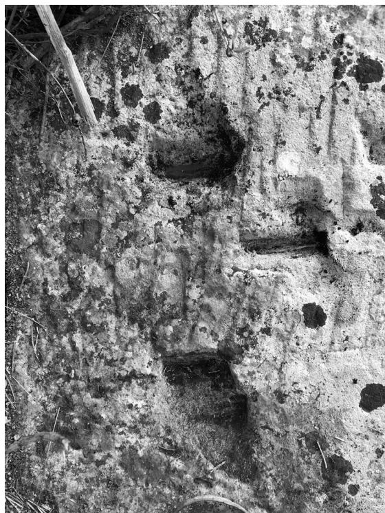
Fig. 23. Filiporto. Incassi per grappe nei conci della fortificazione.
