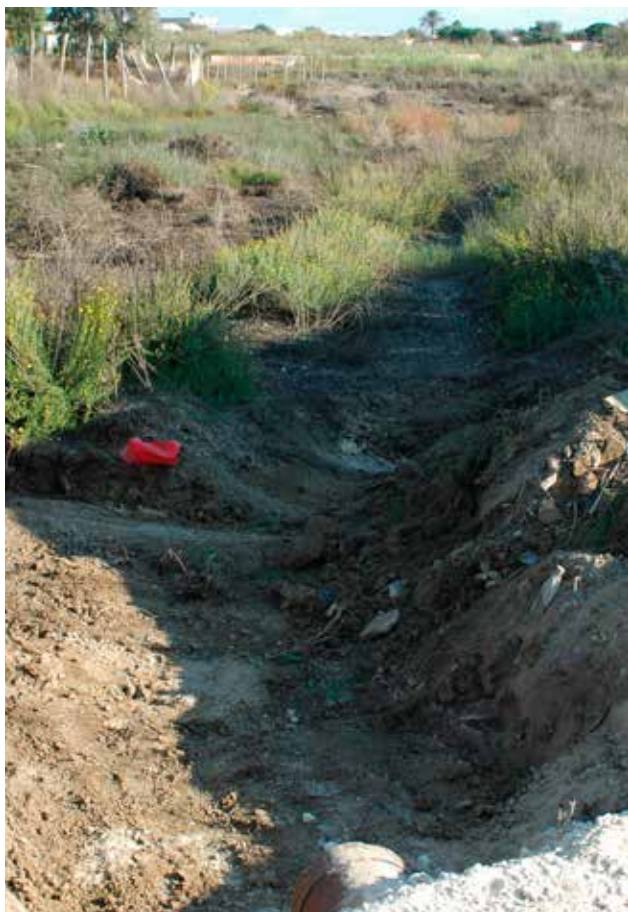
Fig. 11.12 Lavori di ripristino del collegamento idrico tra i due lati del pantano separati dalla strada podereale
