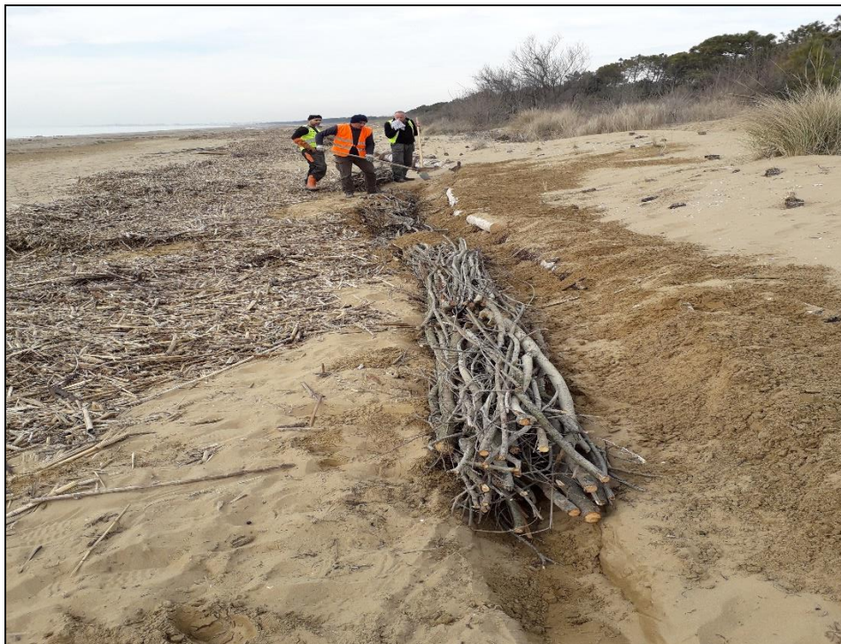
Figura 4: Scavo del fossato e inserimento delle fascinate alla base della duna
