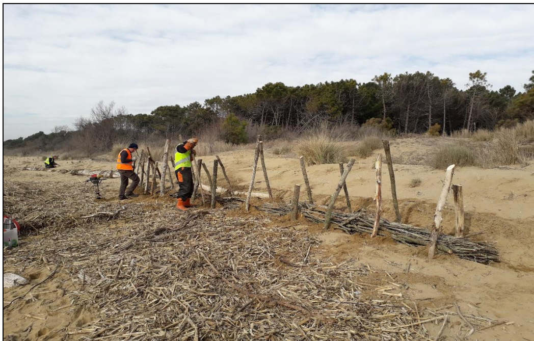
Figura 5: Palificate atte a stabilizzare le fascine
