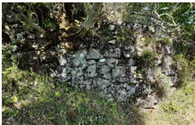
Fig. 41 – Monte Bastiglia. Mura orientali, torre Nord. La torre risulta poco leggibile a causa della fitta vegetazione che la ricopre (foto Alfredo Nicastri)
