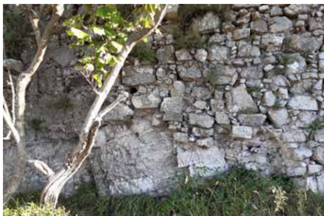
Fig. 34 – Monte Bastiglia. Particolare di un tratto delle mura dell'ambiente di guardia all'ingresso principale (angolo SE), impostato sulla roccia (foto Alfredo Nicastrì)
