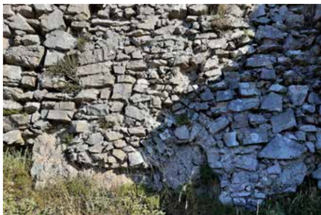
Fig. 33 – Monte Bastiglia. Particolare di un tratto delle mura meridionali impostato sulla roccia (foto Alfredo Nicastrì)
