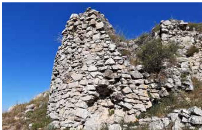
Fig. 39 – Monte Bastiglia. Mura orientali, torre mediana. La torre risulta integrata alle mura perimetrali (foto Alfredo Nicastri)
