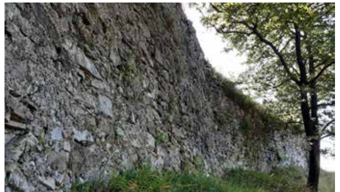
Fig. 82 – Monte Bastiglia. Versante Sud, muro di contenimento del terrazzamento (foto Alfredo Nicastrì)
