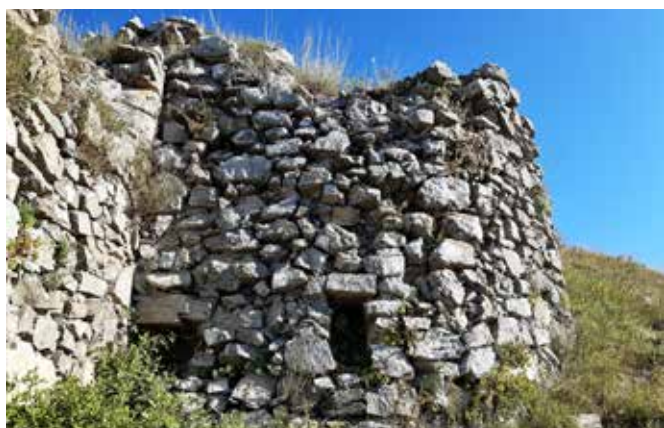
Fig. 40 – Monte Bastiglia. Mura orientali, torre Sud. La torre risulta giustapposta alle mura perimetrali ed è dunque presumibilmente ascrivibile a una seconda fase edificatoria (foto Alfredo Nicastri)
