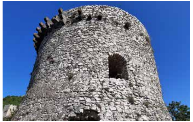
Fig. 68 – Castello di Mercato San Severino. Terza cinta muraria, torre d'età angioina, riconoscibile per la forma cilindrica su base leggermente scarpata (foto Alfredo Nicastrì)
