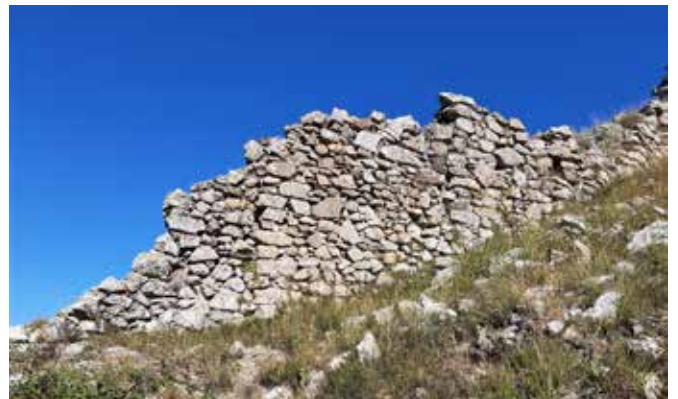
Fig. 81 – Monte Bastiglia. Particolare delle mura, lato Est. Da notare l'assenza di evidenti piani di posa (foto Alfredo Nicastrì)
