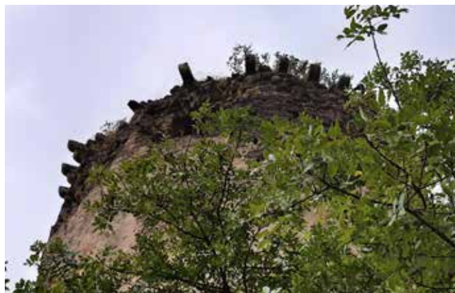
Fig. 60 – Castel Vetrano, Fuorni. Particolare del dongione, caditoie (foto Alfredo Nicastrì)
