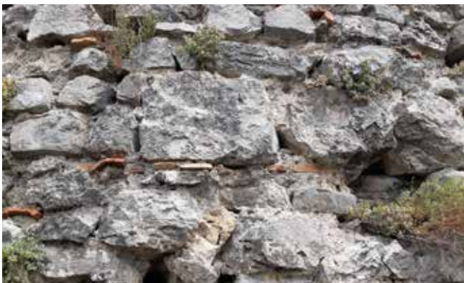
Fig. 66 – Castello Merola, San Mango Piemonte. Particolare della tecnica costruttiva della torre. Si può notare l'uso di frammenti di laterizi inseriti orizzontalmente tra i conci per consolidarne la giacitura sui piani di posa (foto Alfredo Nicastrì)
