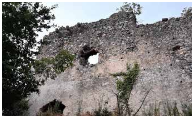
Fig. 61 – Castel Vetrano, Fuorni. Particolare della cinta muraria, lato Est. Da notare le caditoie posizionate a difesa dell'ingresso sottostante (foto Alfredo Nicastrì)
