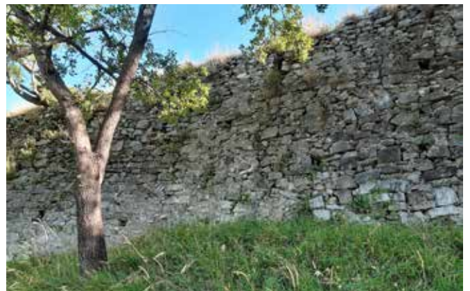
Fig. 83 – Monte Bastiglia. Versante Sud, particolare del muro di contenimento del terrazzamento (foto Alfredo Nicastrì)
