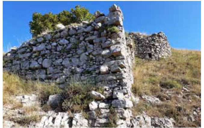
Fig. 80 – Monte Bastiglia. Particolare delle mura, spigolo SE e torre meridionale. Si possono individuare i piani di posa orizzontali, marcati da filari di pietre di dimensioni maggiori. Gli stessi non sono presenti nella torre e nelle mura adiacenti (foto Alfredo Nicastrì)
