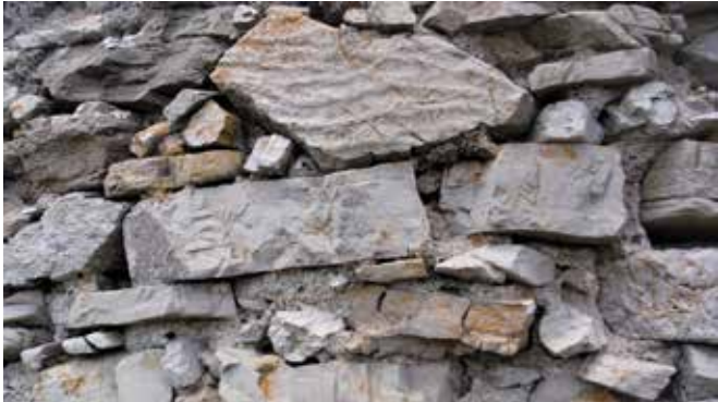
Fig. 77 – Monte Bastiglia. Particolare delle mura. Si può notare l'irregolarità della messa in opera, l'utilizzo di pietre di diverse forme e dimensioni, il non rispetto della giacitura orizzontale, l'abbondante uso di malta come collante (foto Alfredo Nicastrì)
