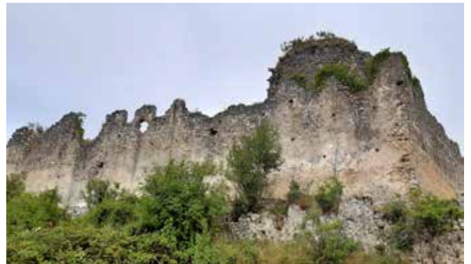
Fig. 70 – Castel Vetrano, Fuorni. Particolare della cinta muraria, angolo Nord Ovest. È ancora riconoscibile parte della merlatura con aperture adatte anche all'uso delle armi da fuoco (foto Alfredo Nicastrì)
