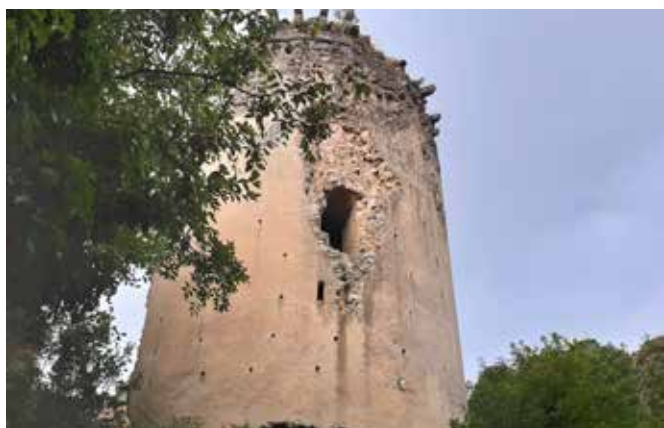
Fig. 50 – Castel Vetrano, Fuorni. Dongione. L'apertura al pianterreno è successiva, l'entrata originaria era collocata al piano superiore e vi si accedeva con una scala esterna. (foto Alfredo Nicastrì)
