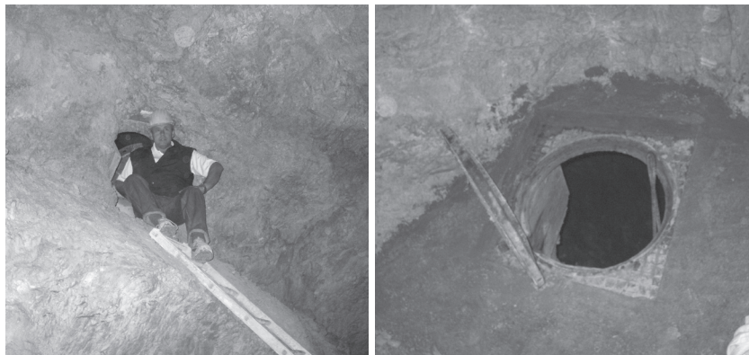
Tombino di ingresso alle grotte realizzato nella parte terminale della Galleria
