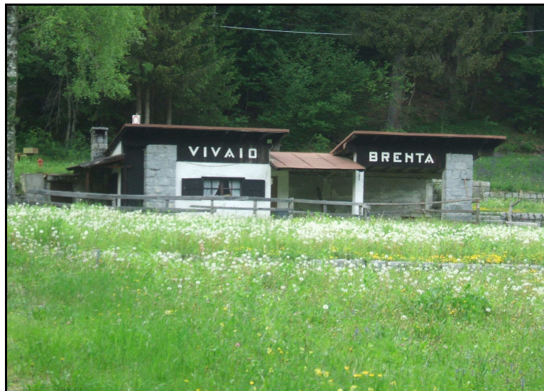
Figura 6: L'edificio al servizio dell'ex vivaio (Foto degli Autori)
