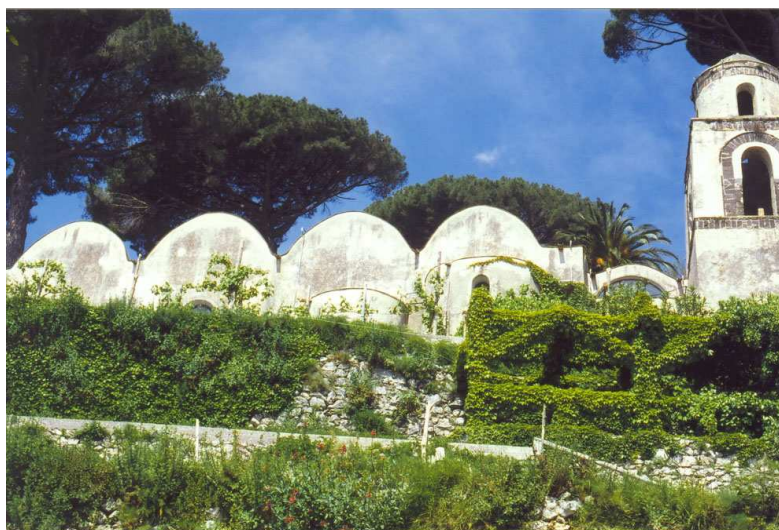
Ravello. Chiesa dell' Annunziata. Copertura con volte estradossate
