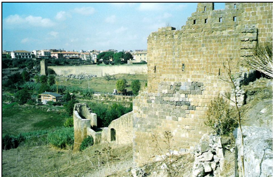
Fig. 19 e 20 – Torre T24 e muro che sale verso il palazzo visti nord; torre T24 e muro che sale verso il palazzo visti sud.
