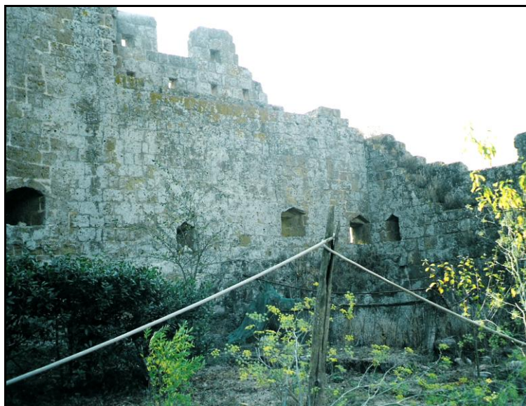
Fig. 21 – Muro meridionale ripreso da nord
