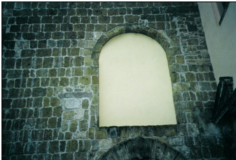
Fig. 27 – Antico finestrone tamponato.
