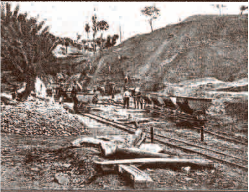
MINIERA DI CA MAGGIO. - L'INTERNO DELLA MINIERA E SERVIZI DI COMPLESSIVITÀ ALL' APERTO.
