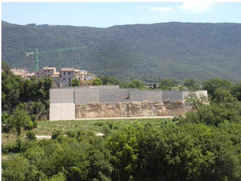
Fig. 8 – Massa Martana (Rupe) – Vista della parete occidentale dopo gli interventi di consolidamento (foto SGA).
