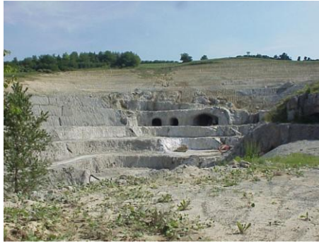
Fig. 6 – Il fronte gradonato con alcuni saggi di gallerie per la coltivazione in sotterraneo nella cava di gesso di Moncucco.
