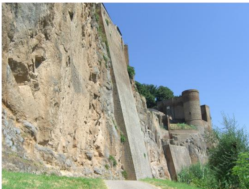
Fig. 9 – Orvieto (TR) – Vista della rupe dopo gli interventi di consolidamento.
