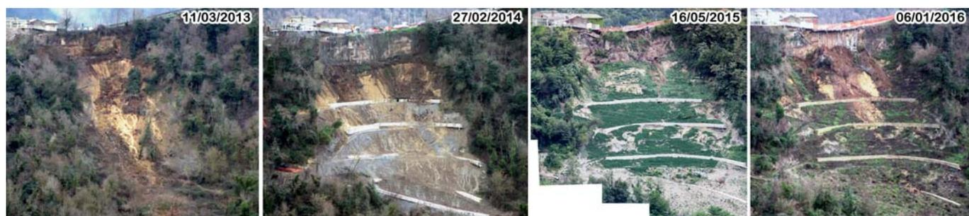
Figura 5 – Versante nord di Mercatello. La soletta in calcestruzzo armato adiacente al fabbricato (in alto, al centro delle foto dal 2014 in poi), trovandosi sospesa per diversi metri sopra il tufo crollato è stata oggetto di un intervento di messa in sicurezza alla fine del 2015 (pali fondati in profondità nelle argille)
