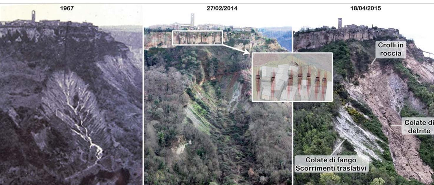
Figura 8 – Il "cavon grande": evoluzione dell'area e indicazione dei fenomeni in atto (nel riquadro al centro il settore in cui oltre 10 anni fa sono stati realizzati 7 pozzi strutturali per stabilizzare il ribaltamento di un grande prisma di roccia)
