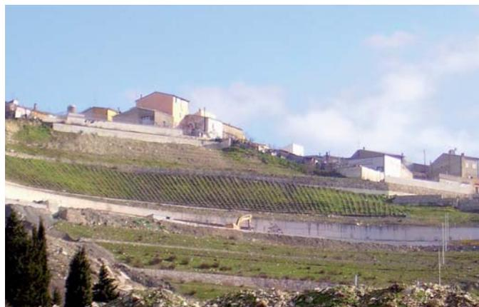
Figura 19 – Sistemazione con drenaggi profondi e tecniche di ingegneria naturalistica (b) della scarpata principale di frana del versante sotto l'abitato di Carlantino (Fg) affetto da intensa franosità regressiva (a)
