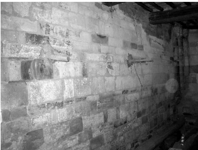
fig. 25 – San Pietro d'Asso. Muro meridionale del transetto della chiesa romanica.
