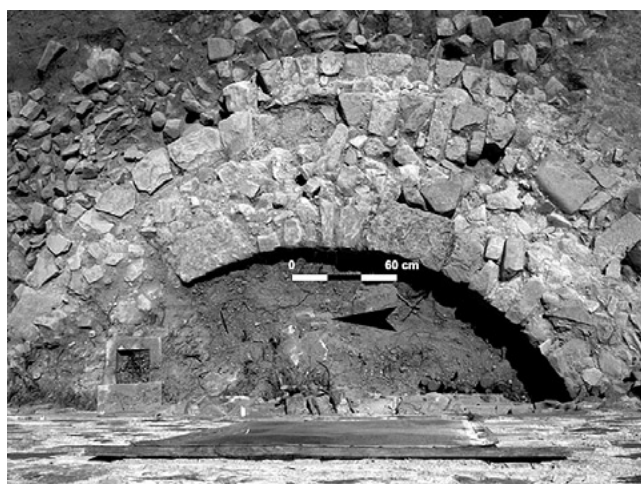
fig. 14 – Area 4500. Veduta dalla finestra del podere della rasatura dell'abside centrale.
