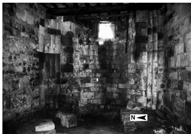
fig. 23 – San Pietro ad Asso. Interno della cantina in cui sopravvivono l'abside e gli stipiti della originaria chiesa romanica.
