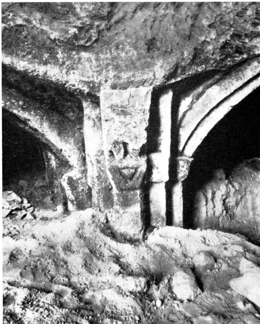
Fig. 96 – ISCHIA DI CASTRO, LOCALITÀ POGGIO CONTE, CHIESA RUPESTRE, INTERNO, PARTICOLARE DEI PILASTRI DEL PRIMO AMBIENTE.
