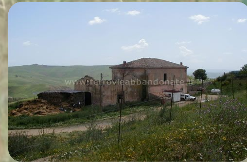
Ex tratto Dittaino - Leonforte
