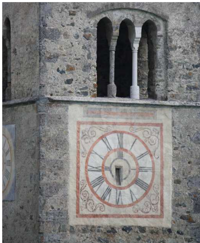
Figura 2. Particolare della torre dell'orologio
