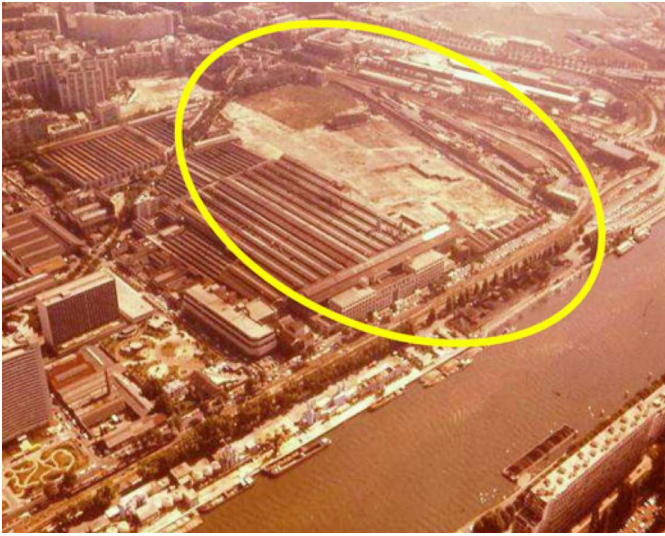
Figura 3. Quartiere Citroën, vista dell'area prima dell'intervento di riqualificazione del quartiere.
