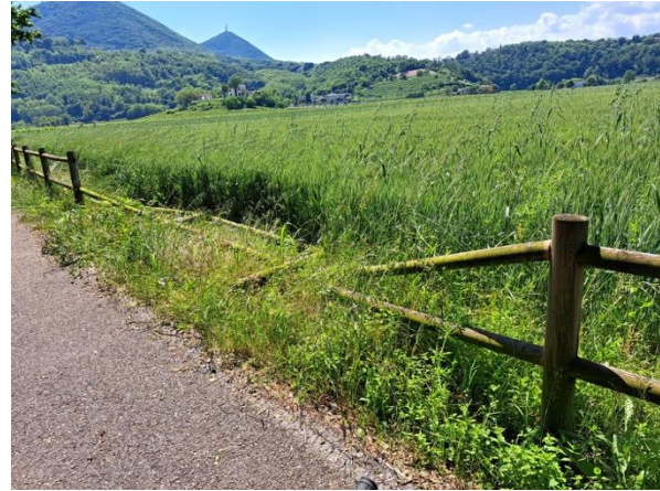
Figura 6.7 Staccionata in degrado. Comune di Cervarese S. Croce (PD)
