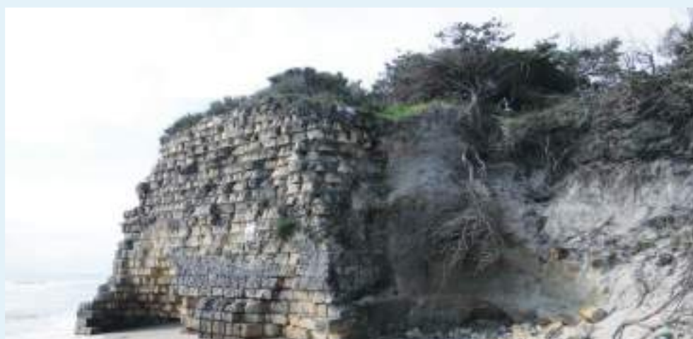
Vista da Nord di Torre Fiumicelli; la stabilità della struttura è minacciata dall'azione del moto ondoso
