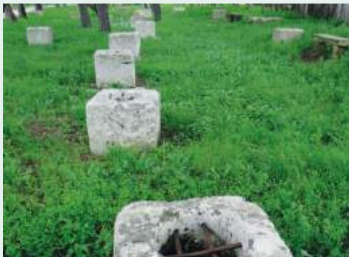
Cubi di pietra leccese costituiscono l'imbocco "vera" delle pozzelle realizzate sul fondo di una ampia dolina di soluzione
