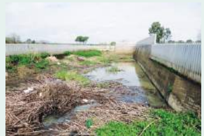
Le acque convogliate dal Canale Fontanelle si immettono nel sottosuolo attraverso un inghiottitoio carsico il cui imbocco è completamente obliterato dalle opere idrauliche
