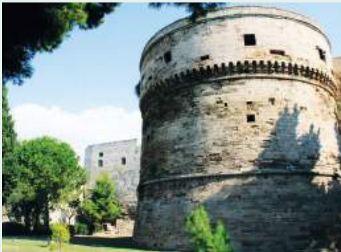
Buona parte delle strutture del Castello Aragonese risalente al 1492 sono realizzate con blocchi delle calcareniti affioranti nel sito
