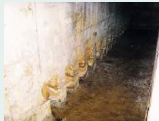
Dettagli delle opere interne all'acquedotto: in alto, la sezione della galleria rivestita in conci di calcarenite; in basso, un tratto del condotto di raccolta (foto di M. Marroccoli per G. De Giorgio)
