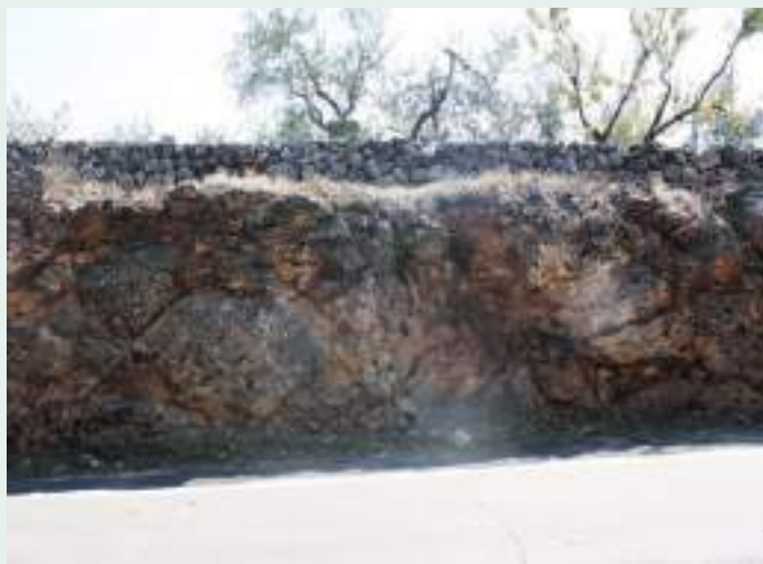
Trincea stradale della SP180 in cui è possibile osservare grandi blocchi di breccie dolomitiche disposti in maniera caotica
