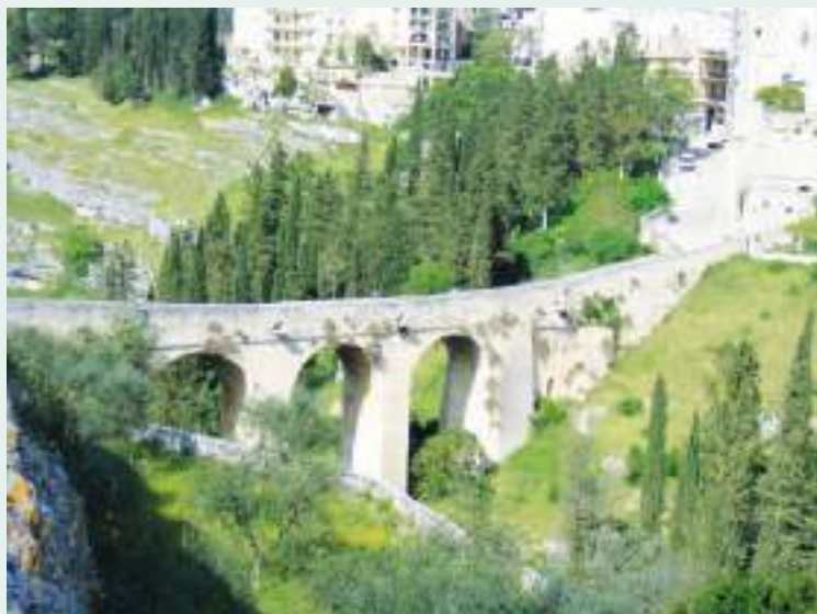
L'acquedotto, in corrispondenza dell'attraversamento della gravina, corre in un ponte-canale
