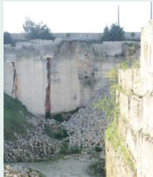
L'imbuco imbutiforme delle ventarole è mascherato dai muri di contenimento realizzati con conci. Il rivestimento è reso necessario dalla presenza di depositi colluviali sciolti di colore rossastro, riccamente fossiliferi
