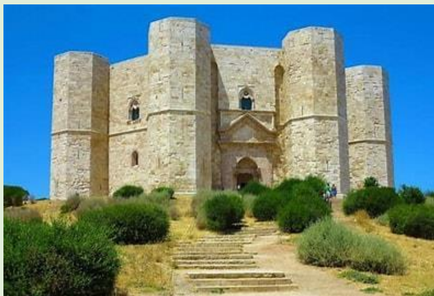
Murge settentrionali: Castel del Monte
