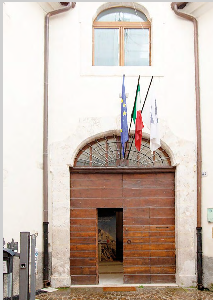
L'ingresso della Sede del CAI L'Aquila
