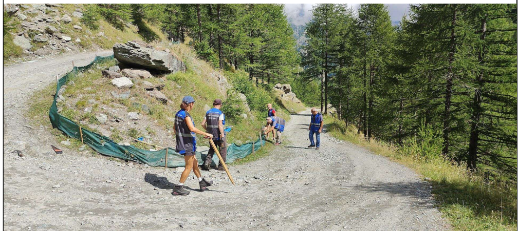
Ripristino delle "barriere per la salamandra" lungo la pista Villanova - Pra
